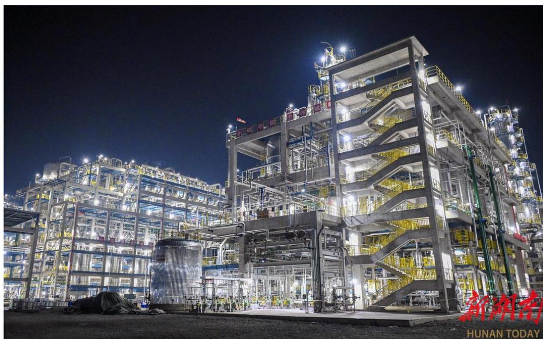
该项目新建己内酰胺装置包括氨肟化、硫酸铵和己内酰胺 3 个生产单元、两条生产线，在主产己内酰胺的同时副产硫酸铵，流程长、设备多、工艺复杂。装置进一步优化提升原有生产工艺，新增固定床催化剂精制、尾气处理系统等新技术，减少“三废”排放，促进节能降耗与产品提质。
