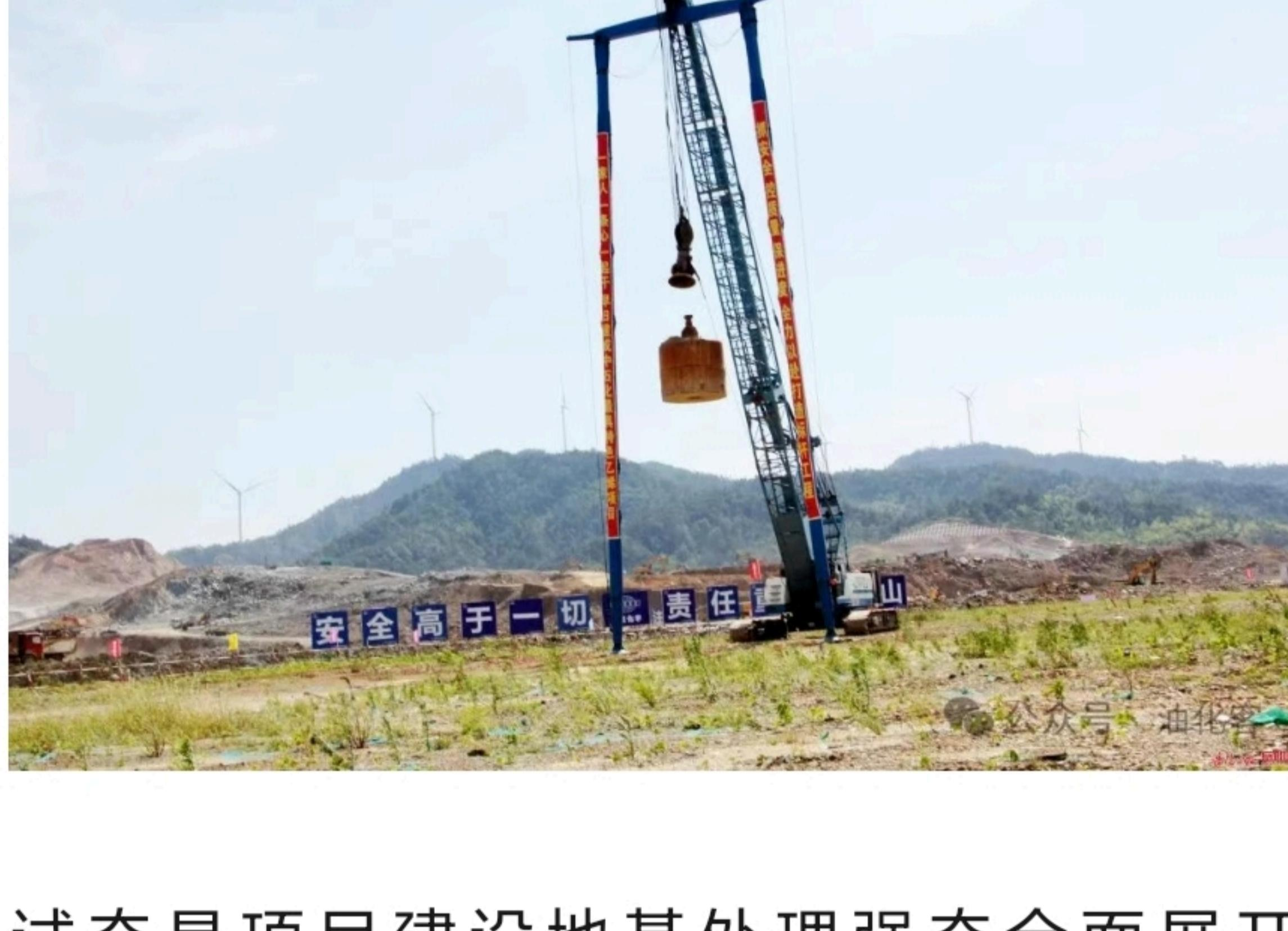
试夯是项目建设地基处理强夯全面展开的前置工序，通过测量沉降参数，可科学评估地基承载能力，论证强夯施工可行性，为项目土建施工提供科学可靠的数据支撑。
